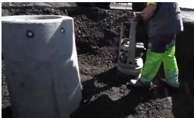
Figur 1: Padda vid sättning av fundament
