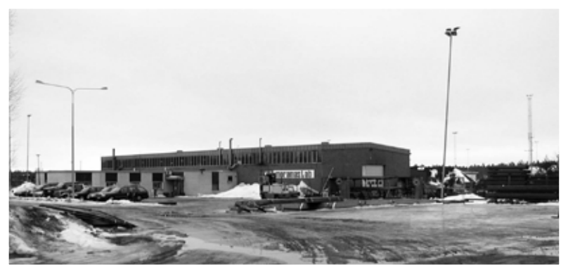
Lokalerna på Vattugatan 11, år 2005, med företagets första logotyp på skylten. Efter detta har kontoret byggts ut med ytterligare rum ut mot vägen samt en övervåning.
